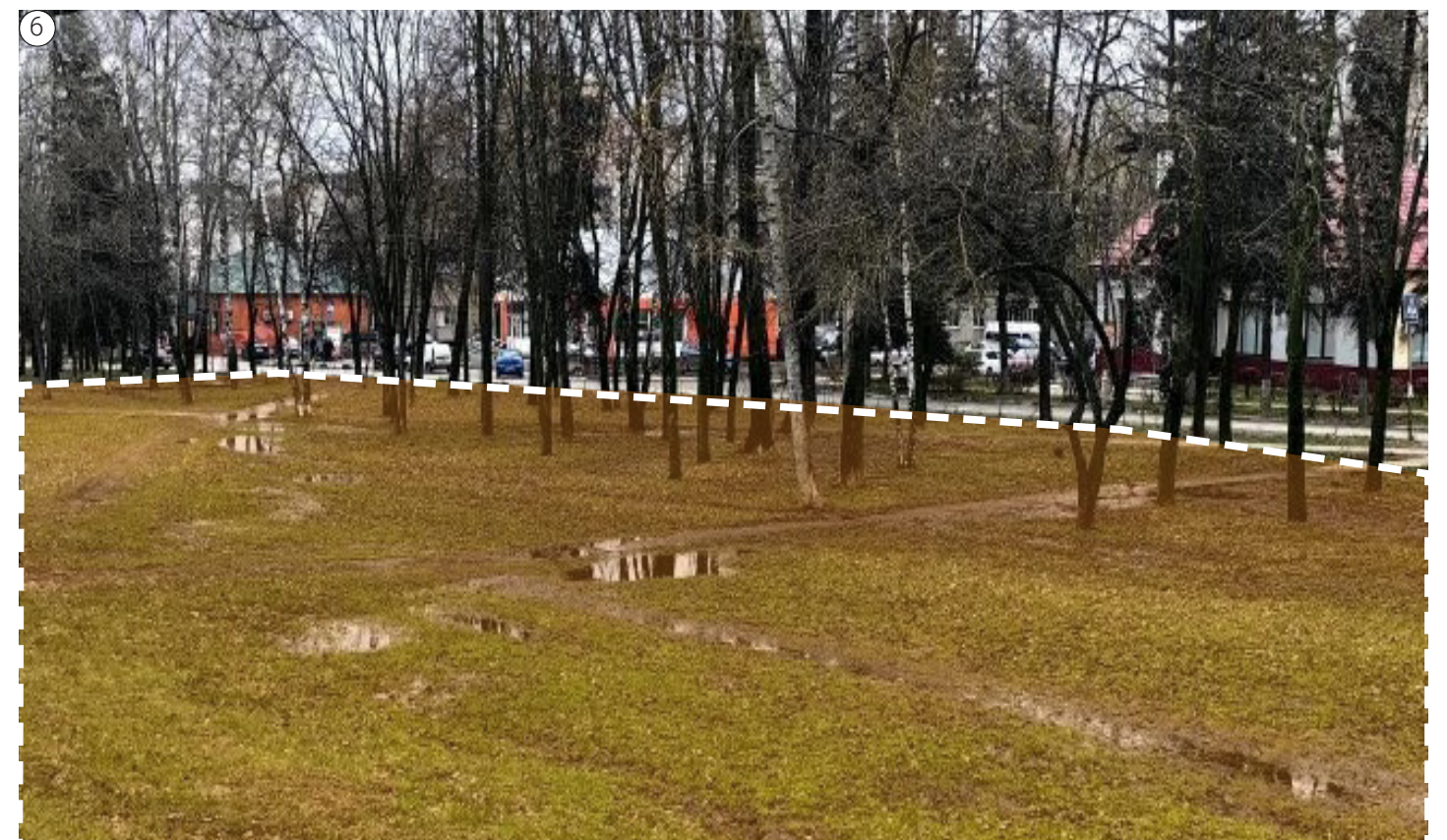
Отсутствие вертикальной планировки, застой воды.
