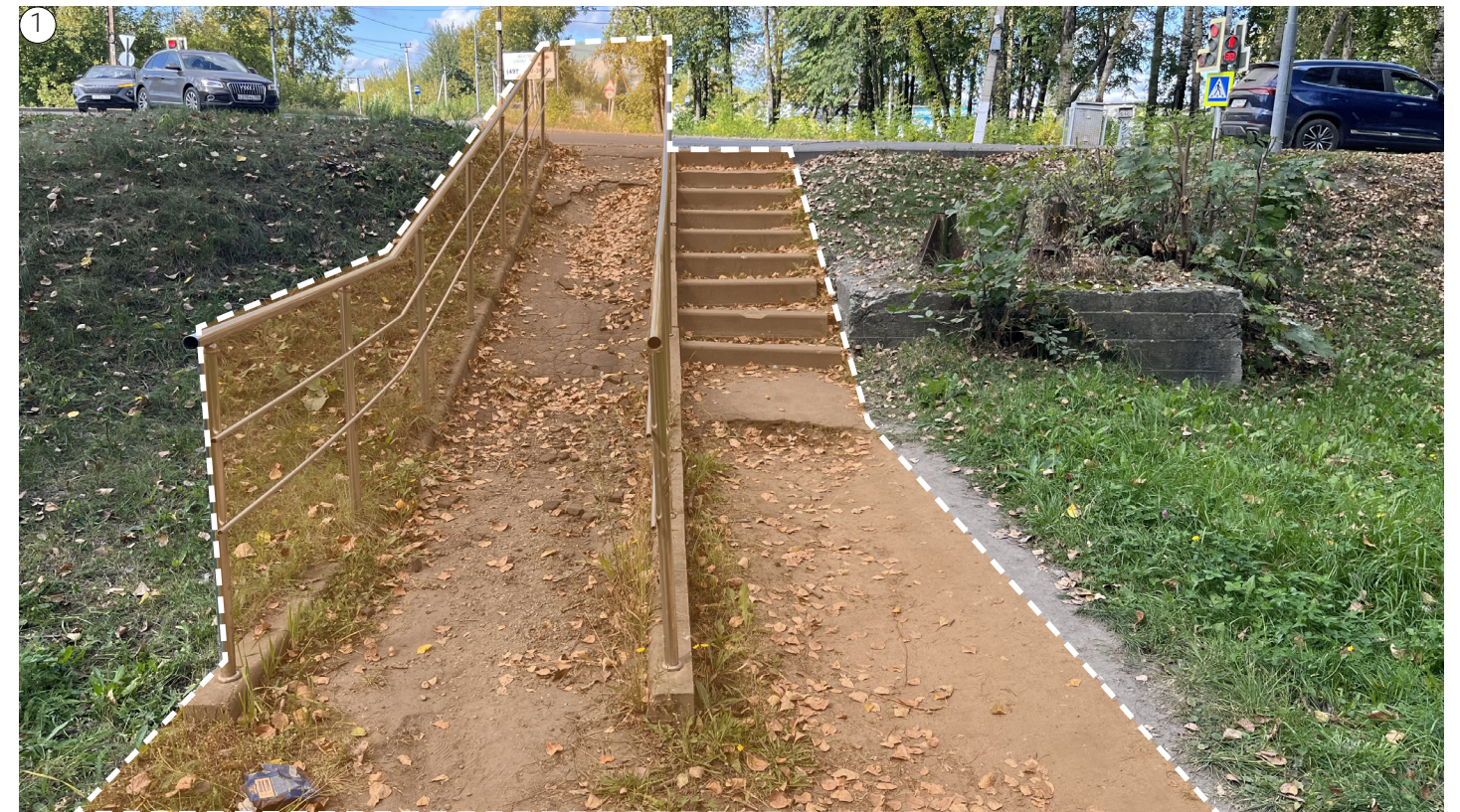
Лестницы в неудовлетворительном состоянии. Уклон пандусов слишком крутой
