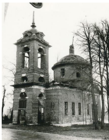
Село Ачкасово. Объект Церковь Казанской иконы Божией Матери», 1819 г. (фото 1987 г.).
