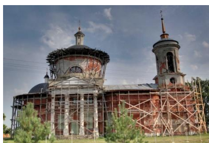
Село Петровское. Объект «Церковь Казанской Божьей Матери», 1812 г. (фото 2011 г.)
