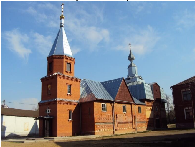
Московская область, городской округ Воскресенск, село Барановское, Центральная ул, дом 134.
