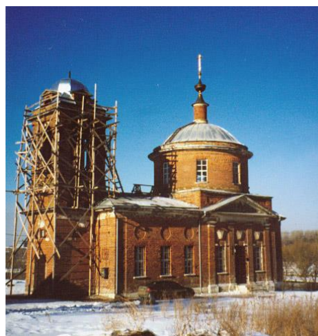
Село Ачкасово. Объект Церковь Казанской иконы Божией Матери», 1819 г. (фото 2011 г.).
