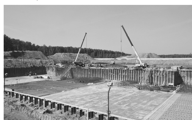
Строительство мусоросжигательного завода в районе д. Свистягино, Воскресенского района.
